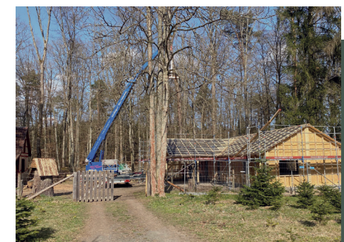
Die Waldkita steht – der Innenausbau soll in den nächsten Wochen erfolgen
