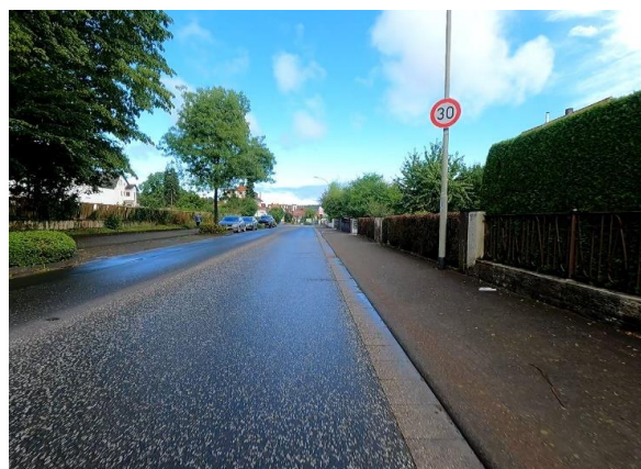
Hungener Straße im oberen Abschnitt
