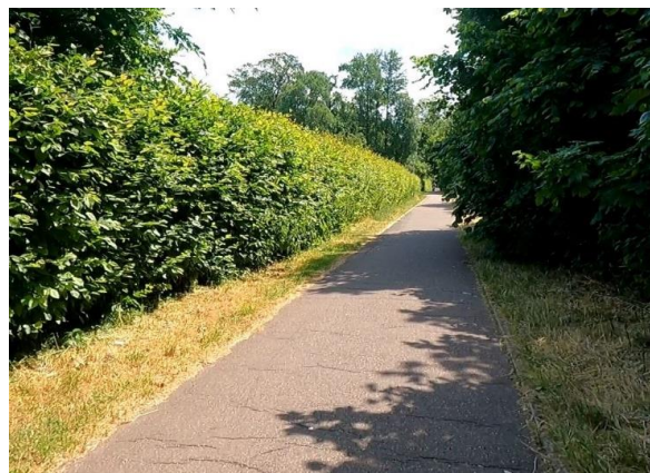
Schlossparkweg mit Schäden
